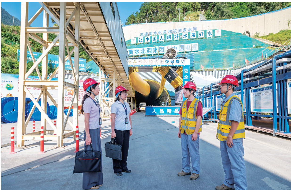
▲ 从严监督执纪是党的自我革命的利器。宜昌市各级纪检监察机关坚持深入一线、扎根基层，以有力有效监督保障重大国家战略落地落实，为长江经济带高质量发展清障护航。图为夷陵区纪检监察干部在太平溪镇南水北调中线引江补汉工程建设现场了解情况。宜昌市纪委监委供图
